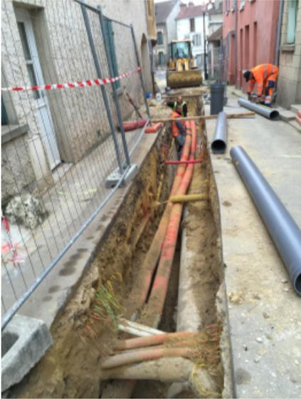
Après des travaux d'enfouissement de lignes électriques et téléphoniques conduits par le SIERC puis ceux du changement de canalisation de gaz par GRDF, Val d'Oise Habitat intervient actuellement rue Montrond pour y passer une canalisation de rejet des eaux.
