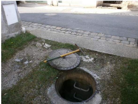
En aval du regard, ouvrage n°6, le ru est acheminé vers un lavoir dans un Ø400.
