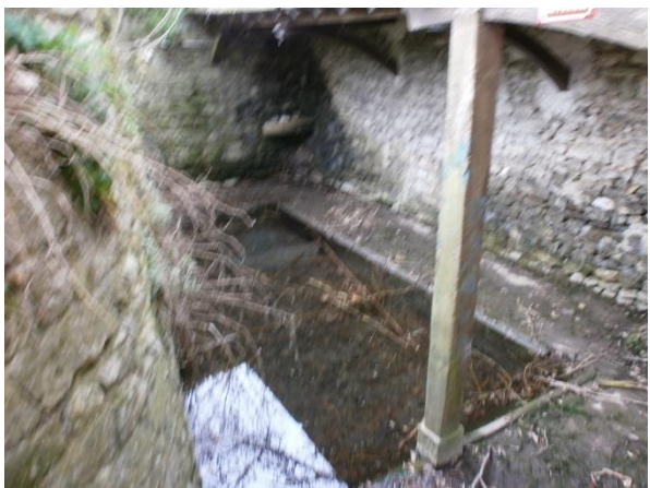
Les investigations ont permis de retrouver la sortie du ru sous la forme d'une ouverture rectangulaire de 0,30m X 0,20m, ouvrage n°4, à la limite de la parcelle du château.
