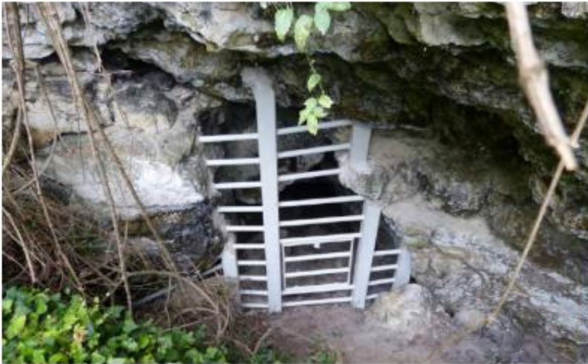
Figure 5 : Aménagement de fermeture de cavité à Vétheuil par un contrat Natura 2000 en 2012
