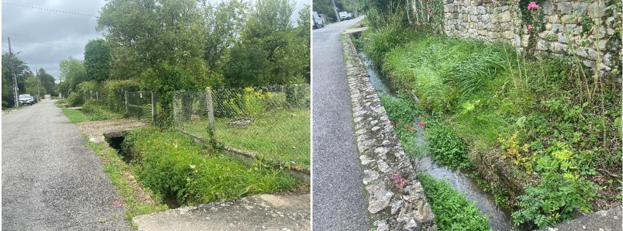
Photo 23 – Petit canal empierré le long de la rue des Croiselles
