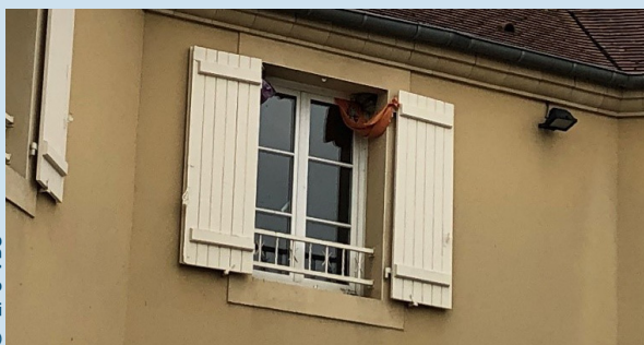
Tissu accroché au-dessus d'une fenêtre et sur le gond d'un volet formant un hamac qui recueille les déjections.
