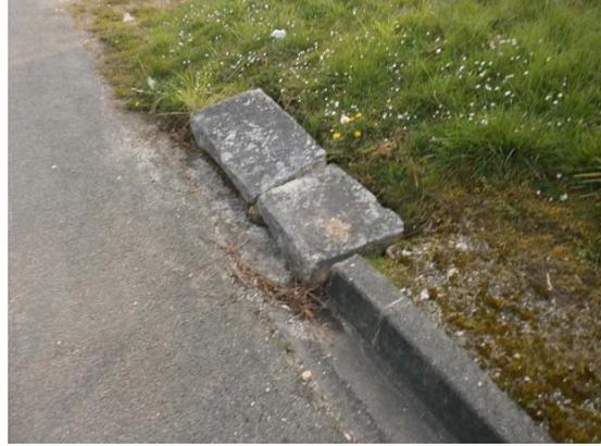
L'eau du lavoir est acheminée par une canalisation vers un avaloir dont la dalle est cassée en deux parties. Une canalisation enterrée traverse la route des Mares, longe le chemin du rocher avant d'arrivée à l'intersection avec la Sente de la Brisoire. Un regard, ouvrage n°2, permet de constater que la canalisation arrive en Ø500, le regard reçoit en outre les eaux pluviales venant de deux grilles par une canalisation Ø300.
