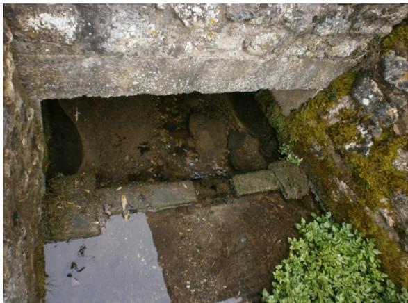
En aval de la traversée de la rue du Parc, il existe un regard avaloir qui est relié à un canal bordant le mur du château. L'entrée du canal, ouvrage n°3, se fait par une ouverture de 0,45m X 0,45m.
