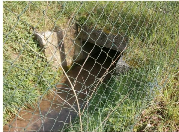
Le bassin s'écoule dans un ouvrage en limite de bassin vers une grille. Cette grille constitue un ouvrage n°4 avec une ouverture carré de 0,60m X 0,60m et un chenal enterré de 1m de large et 0,35m de hauteur.
