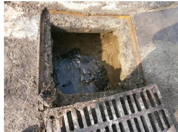
Le ru de la Goulée traverse en diagonale la route des Crêtes qui descend vers Vétheuil. A l'extrémité du chenal enterré, il y a une sortie d'ouvrage n°5 de 1,0m X 0.35m. On note sur la droite une arrivée en Ø300 qui récupère de l'eau de pluie venant d'un avaloir.
