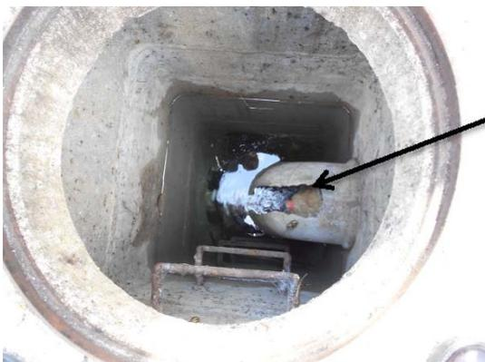
Dépôt de calcaire dans la canalisation venant des drains dans la zone de glissement de terrain
