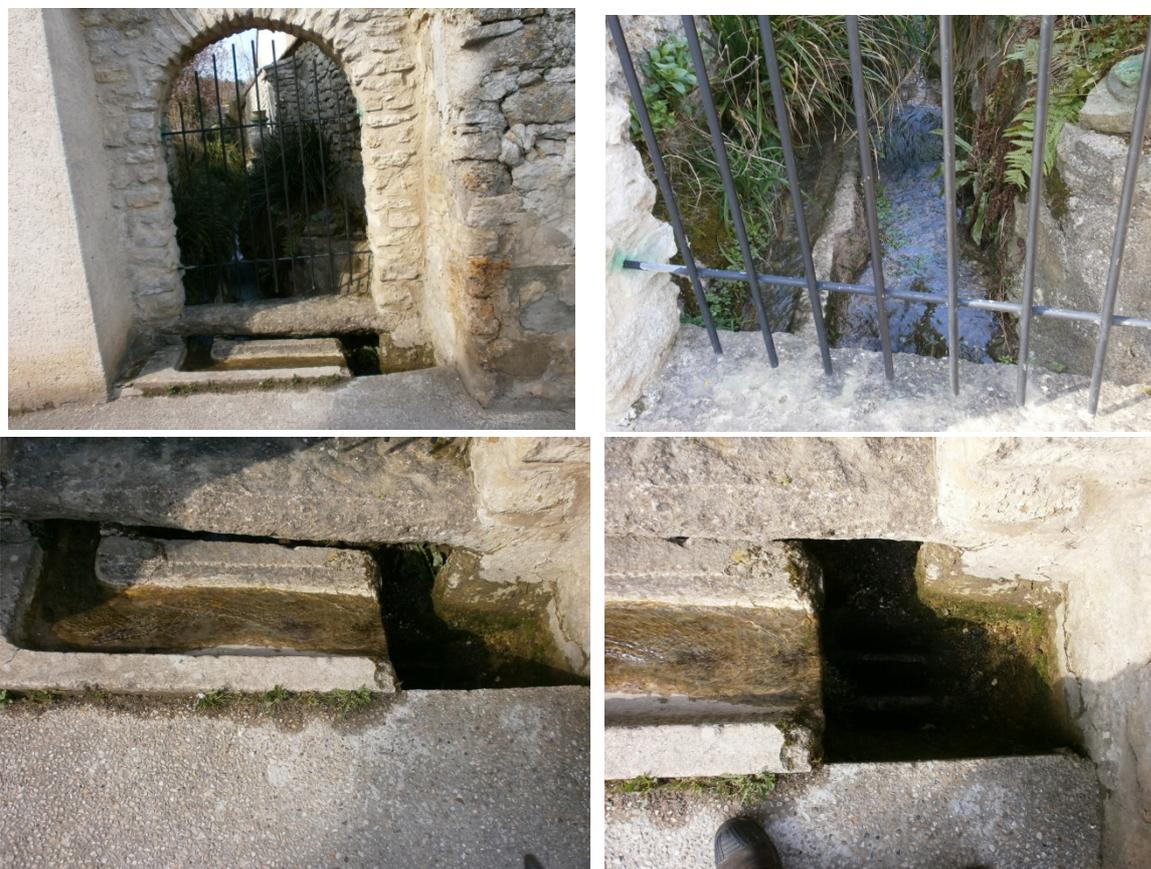
Le ru de la Goulée arrive dans un regard sous la forme d'Ø400. Deux canalisations d'eaux pluviales Ø300 arrivent également dans le regard.
